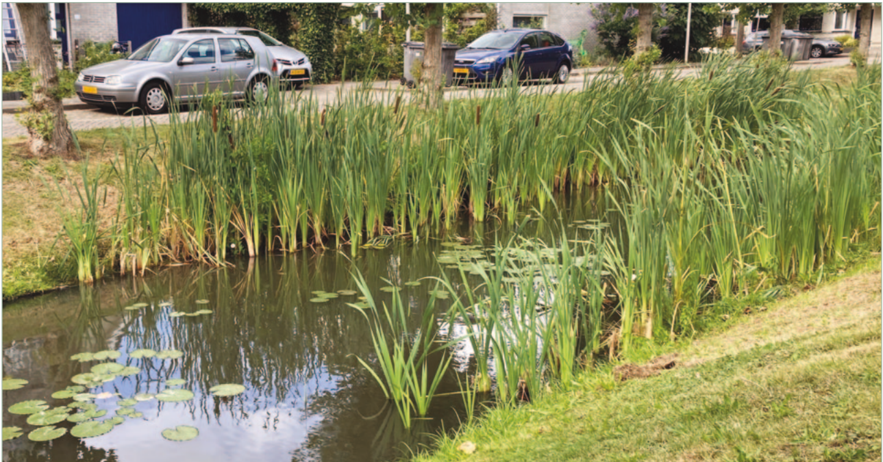
Figuur 7 Voorbeeld van deels beschoeide oever en deels verwijderde beschoeiing, Pinksterbloem Den Hoorn 21 augustus 2024
