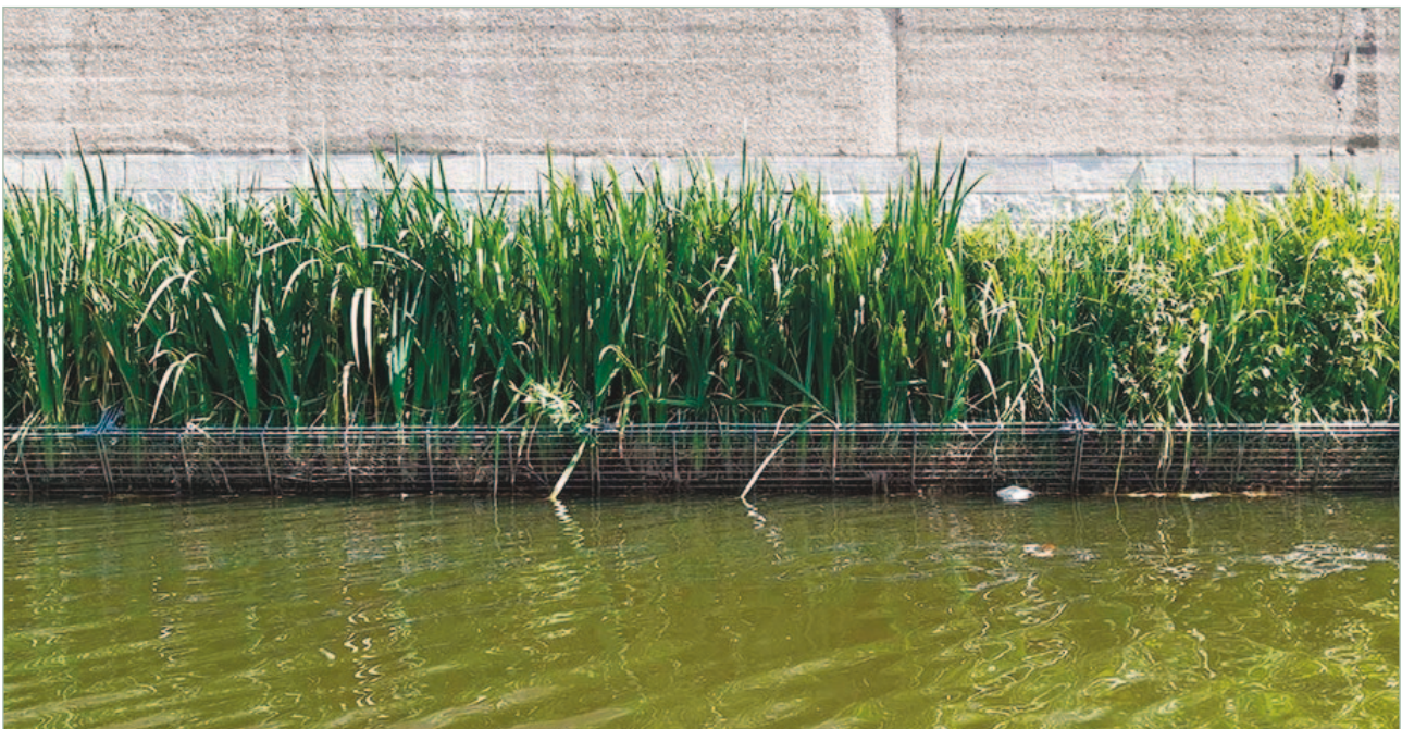
Figuur 18 Foto van de hangende structuren in de Maas in Luik (bron https://www.liege.be/fr/vie-communale/services-communiaux/environnement/plan-nature/fascines-vegetalisees )
