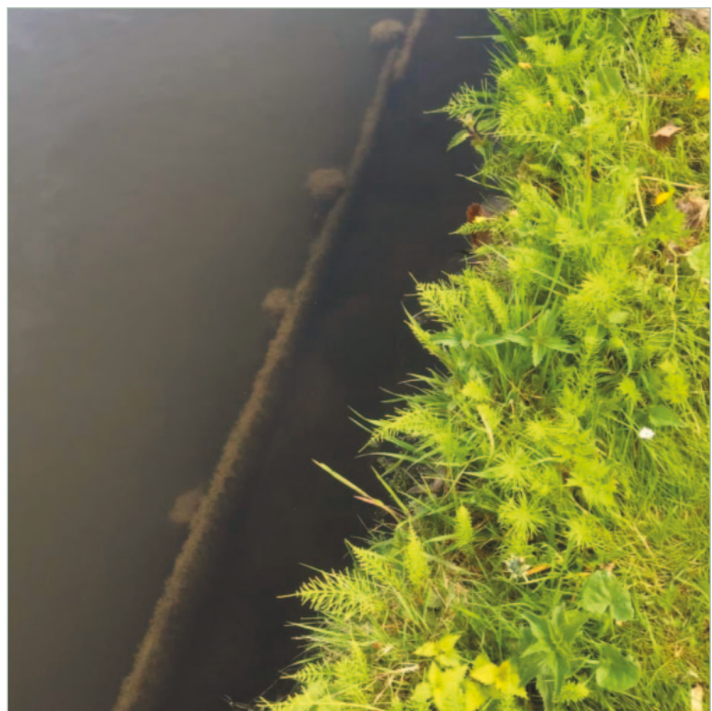
Figuur 30 Plasberm zonder vegetatie (foto Waterschap Hollandse Delta)
