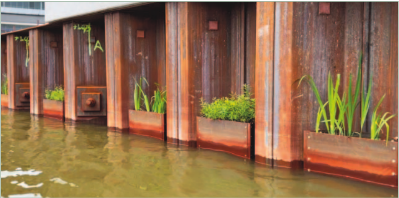
Figuur 16 Plantenbakken (SPECTER) in een damwand, foto van MOSES / Solutions | ReefSystems
