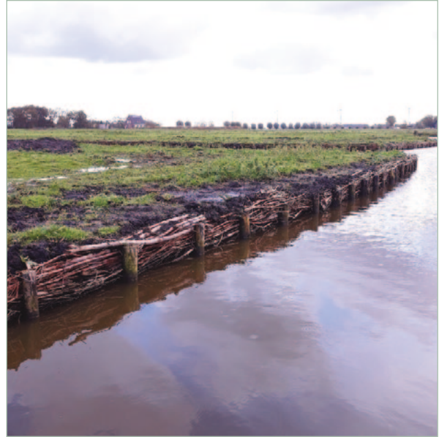
Figuur 21 Afgekalfde oever aangevuld met takken en grond (foto HHR)
