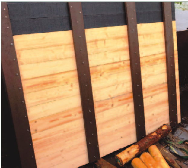
Figuur 25 Combischot met de bovenste deel planken van kunststof of Accoya hout
