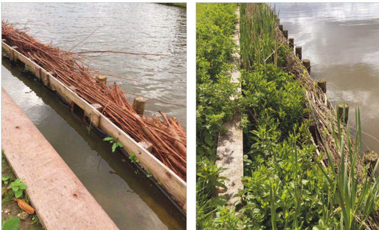
Figuur 5 Gaagweg Schipluiden vooroever voor houten beschoeiing
