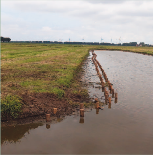
Figuur 20 Palenrij op oorspronkelijke waterlijn (foto HHR)
